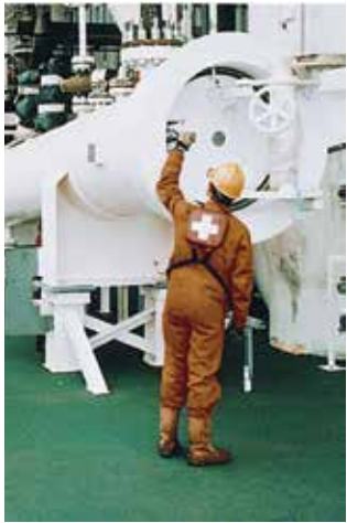
Schritt 1: Ohne den codierten Schlüssel lässt sich die AT frei drehen (Es besteht kein Kraftschluss zur Ventilspindel)
